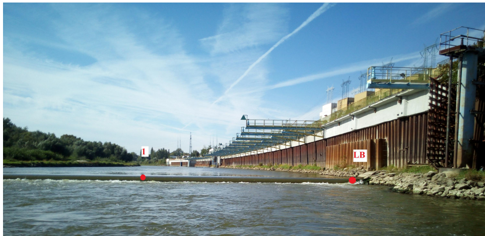
Rys. 3. Lokalizacja profili pomiarowych. Widok na górna wodę.
