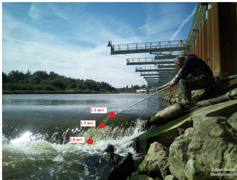
Rys. 5. Jaz piętrzący w Połańcu ,układ punktów pomiarowych. Uzyskane wartości prędkości przepływów. Brzeg lewy
