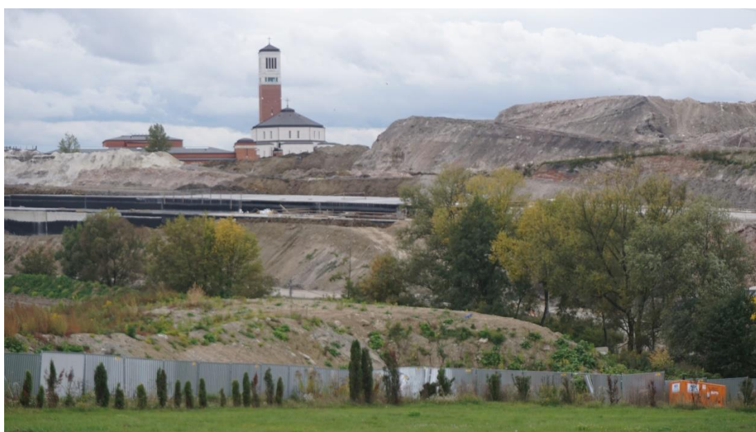
Fot. 1. Widok plac budowy (fot. autorów).
