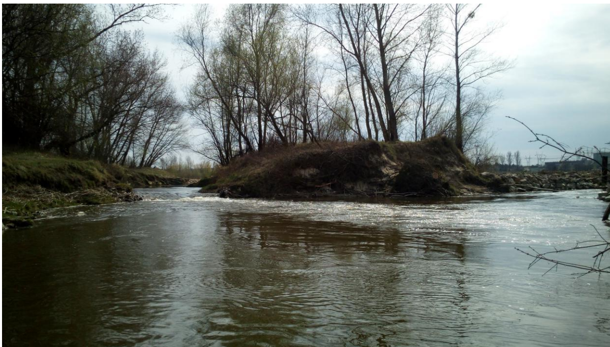
Rys. 7. Prawy brzeg Wisły i naturalnie ukształtowane obejście boczne istniejącego progu. Stan na 10 kwietnia 2019 r.
