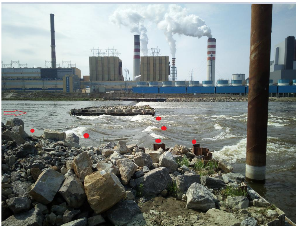
Rys. 3. Schemat przejścia w zaporze Kozienickiej i układ punktów pomiarowych.
