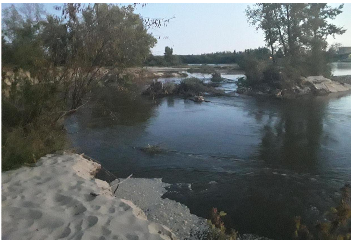
Rys. 10. Prawy brzeg Wisły i naturalnie ukształtowane obejście boczne istniejącego progu. Stan na 22 września 2019 r.
