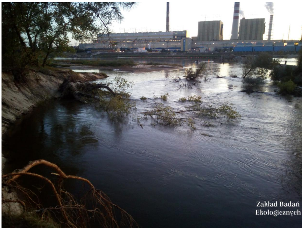
Rys. 11. Prawy brzeg Wisły i naturalnie ukształtowane obejście boczne istniejącego progu. Stan na 22 września 2019 r.
