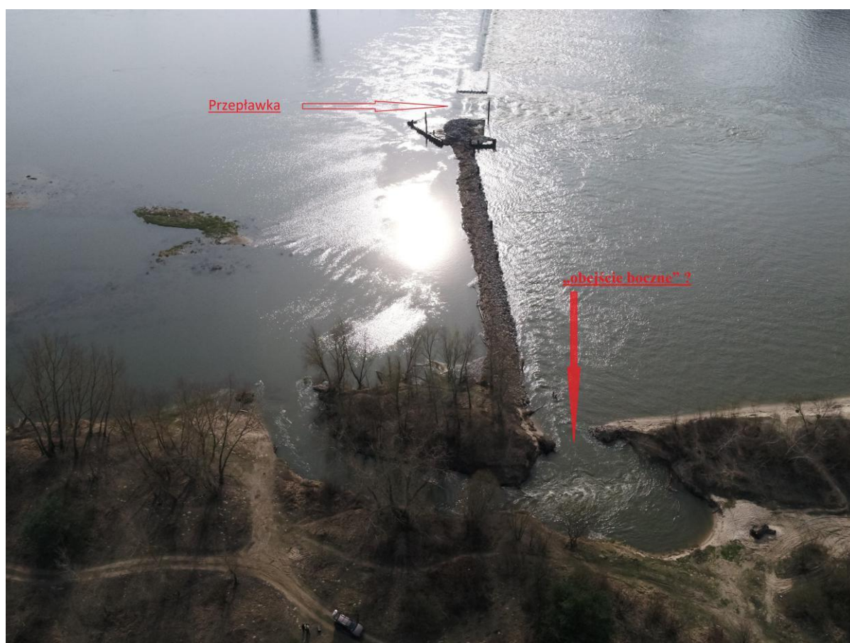
Rys. 6. Prawy brzeg Wisły i naturalnie ukształtowane obejście boczne istniejącego progu.
