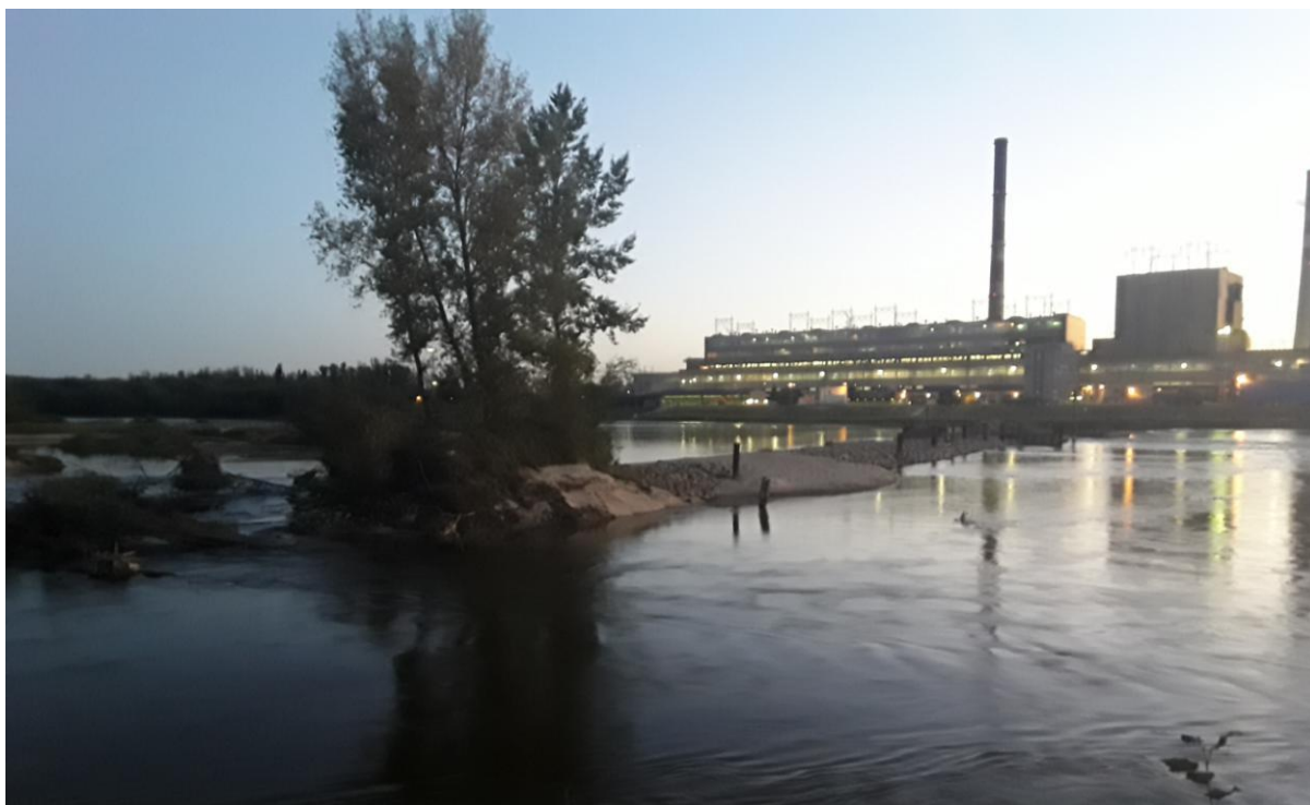
Rys. 9. Prawy brzeg Wisły i naturalnie ukształtowane obejście boczne istniejącego progu. Stan na 22 września 2019 r.
